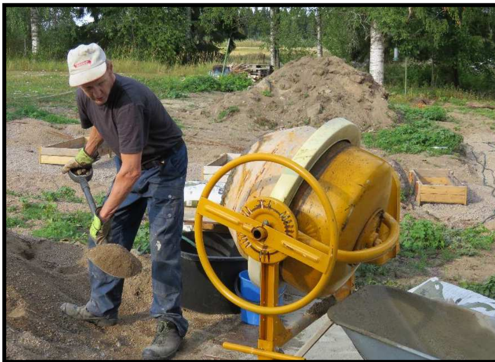
Betonimylllyn pyöritystä Oinoskyläyhdistyksen kylätalolla
