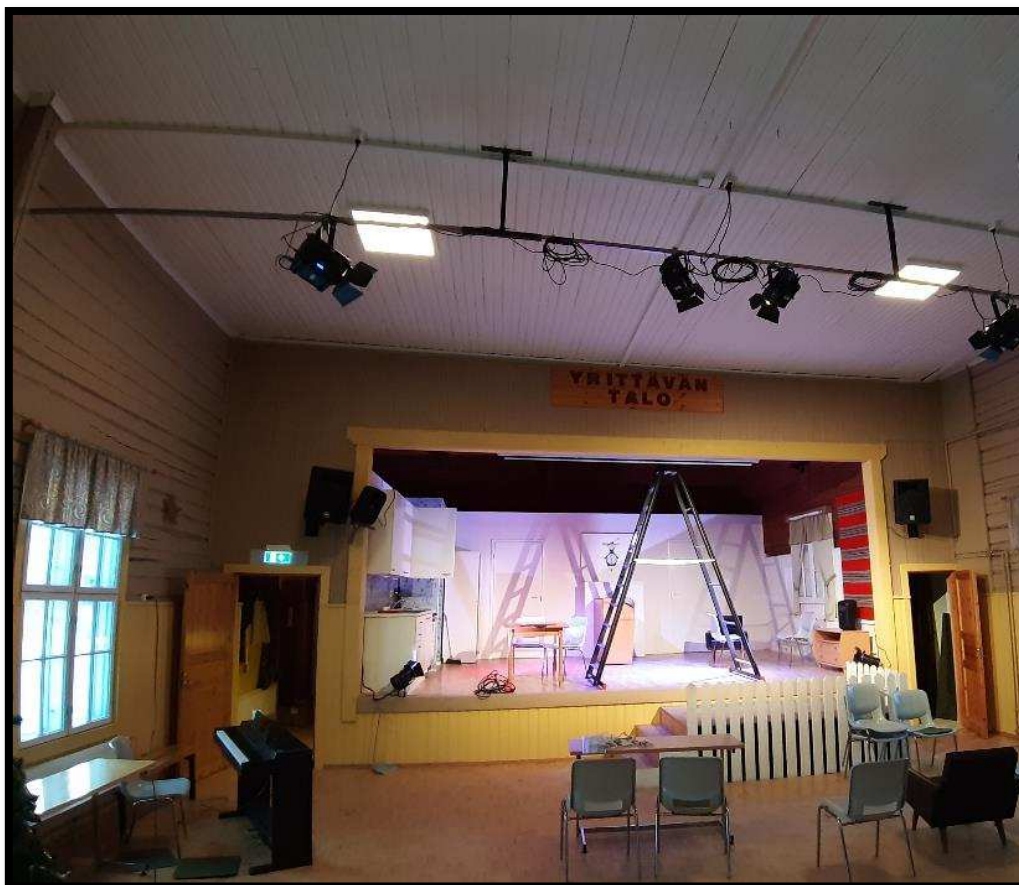
Pääjärven Nuorisoseuran teatterivalojen asennusta
