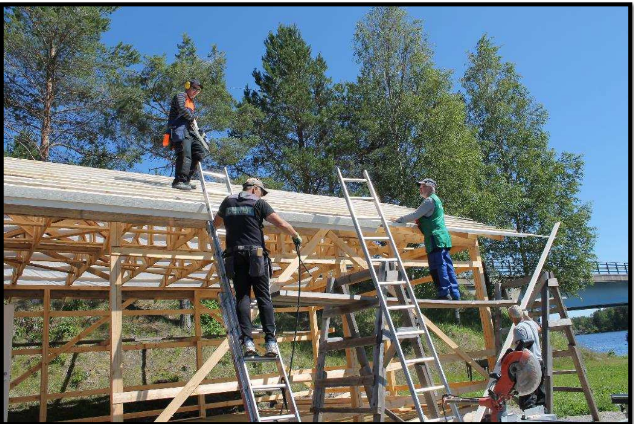
Saaren tuvan rakennustyöt käynnissä
