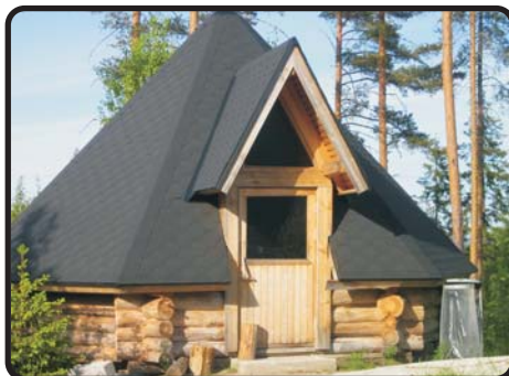
Hankkeella rakennettiin Hanhimäelle kota.
